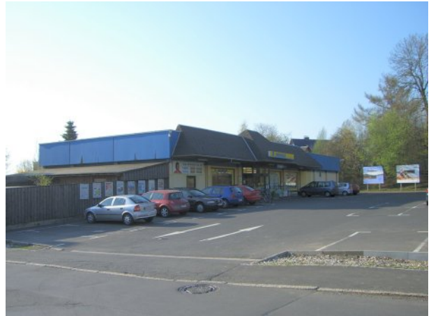
Blick auf das Objekt
